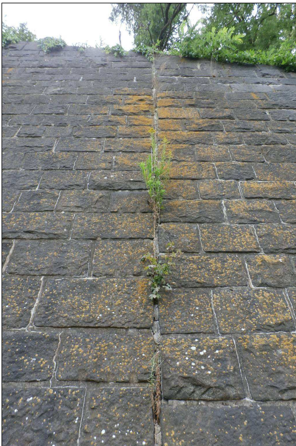
Obr. č. 4 - náletové rostliny uchycené v dilatační spáře
