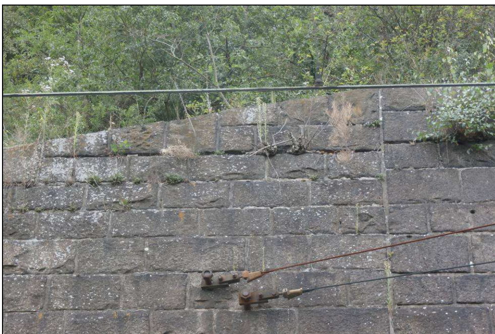
Obr. č. 5 - náletové dřeviny a rostliny v koruně zárubní zdi
